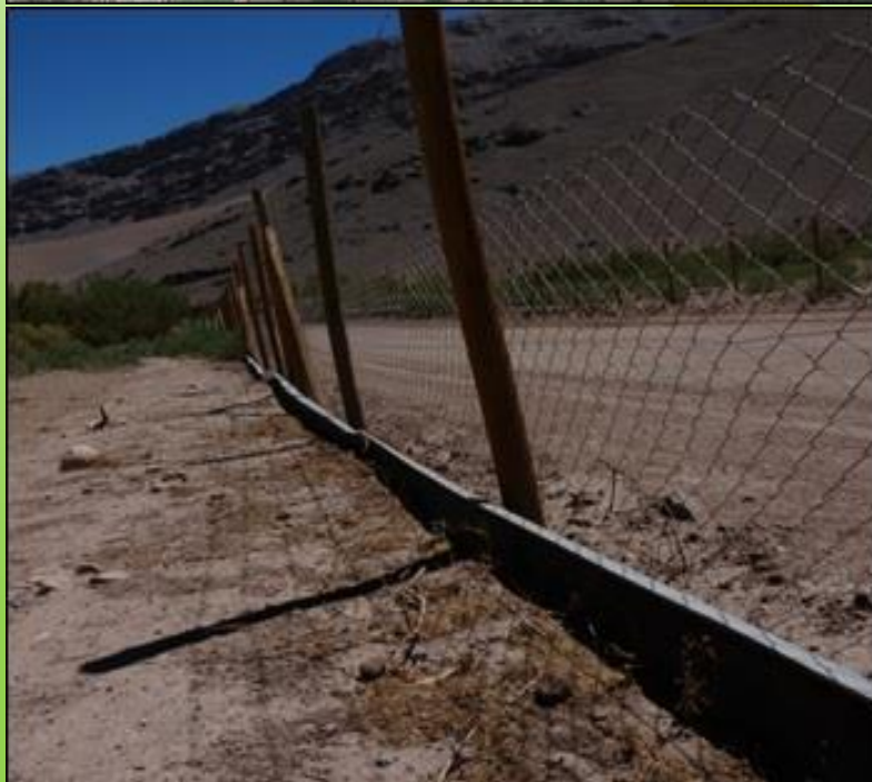
Perimetro de fauna con refuerzos
